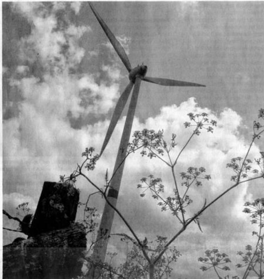
Dieses Windrad dreht sich auf den Höhen im Hagener Süden. Investoren sind bereit, weitere zu bauen. Bis zur Genehmigung ist es noch ein weiter Weg. Derzeit arbeitet die Stadt an einem Flächennutzungsplan. Ein erster Entwurf liegt vor. FOTO: ARCHIV/JS
