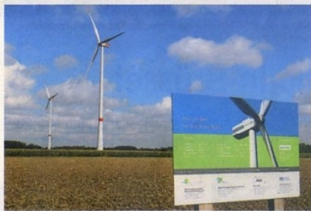
Zwei der drei abgeschalteten Windenergieanlagen im Norden von Werl-Hilbeck. Die Betreiber und Investoren befürchten hohe Verluste.
