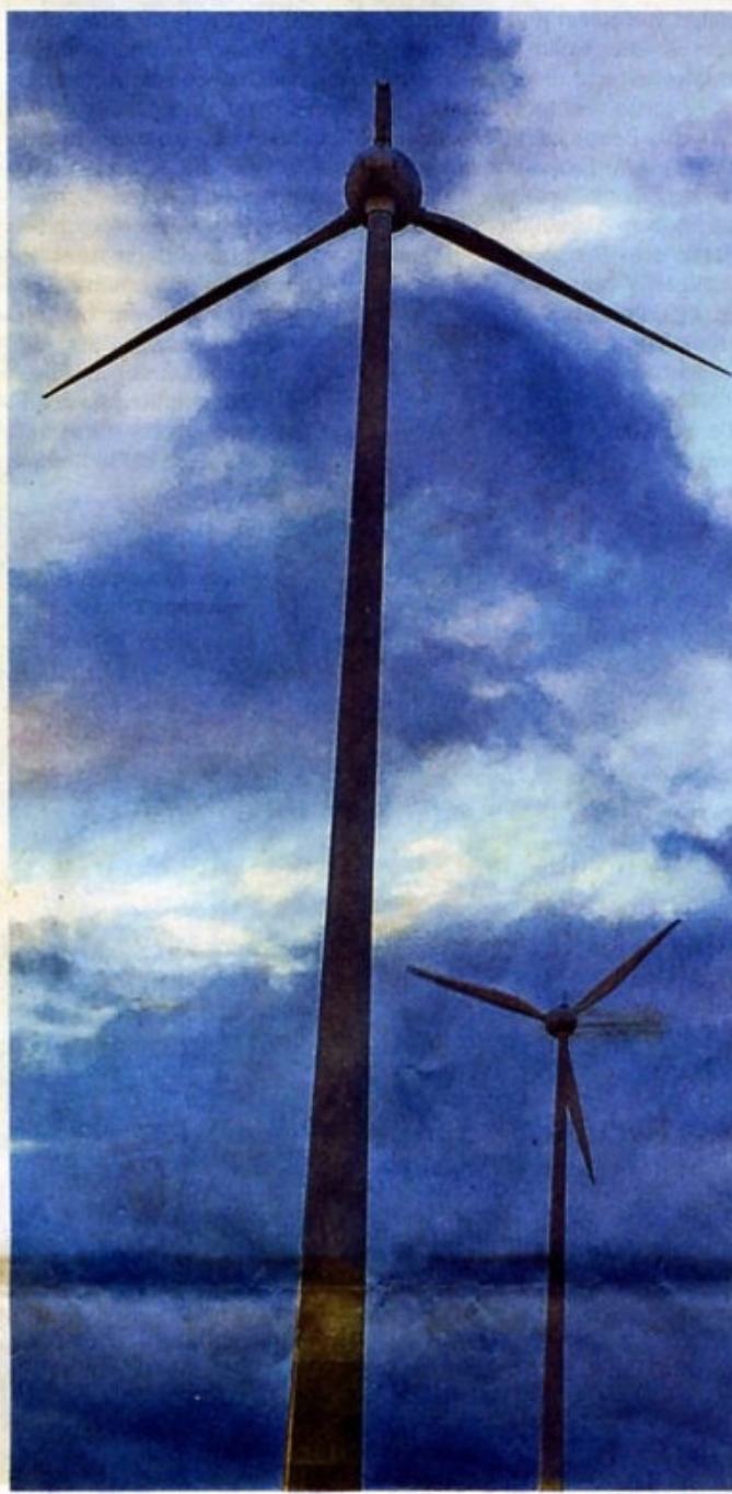
Das Windrad mit dem gebrochenen Rotorblatt in Lippetal-Schöneberg. Die baugleiche Anlage daneben läuft mittlerweile wieder. FOTO: ANDREAS SCHREIBER/KREIS SOEST
